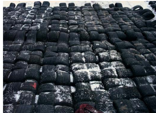
Baustrasse (verbunden) Sprengmatten
