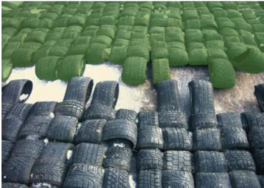
Verbindungsstelle Mattensegmente
