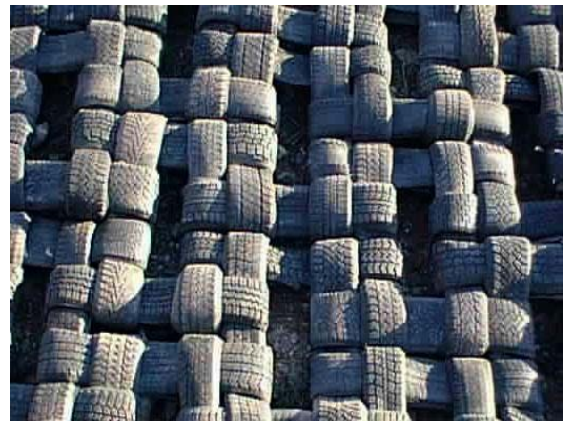
Erosionsschutz Wasserbau Grundsicherung Kanalbau, Hafenbecken Dammstrukturen Erdbau
